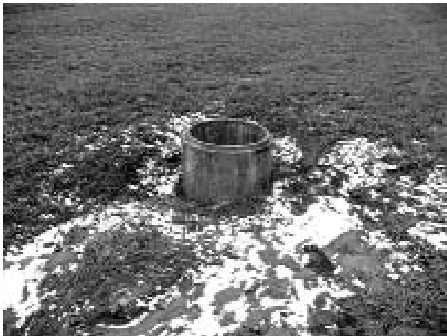
Le trou du Fond-de-la-Souche : la buse de béton qui débouche sur la diaclase du puits d'entrée
