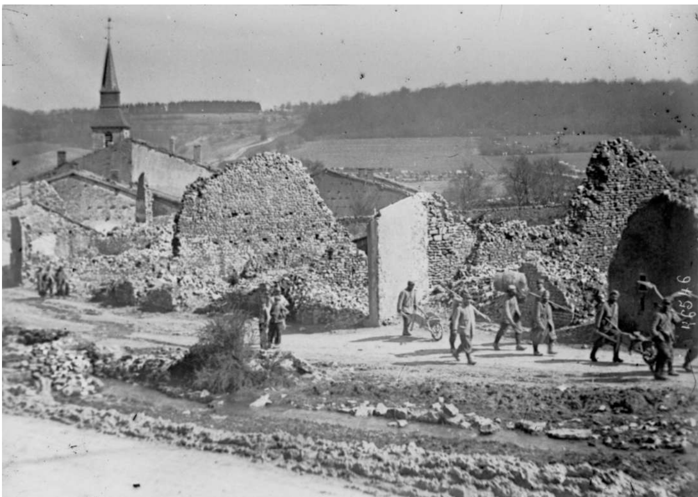
Fig. 13b. Le village de Rampont après les bombardements.
