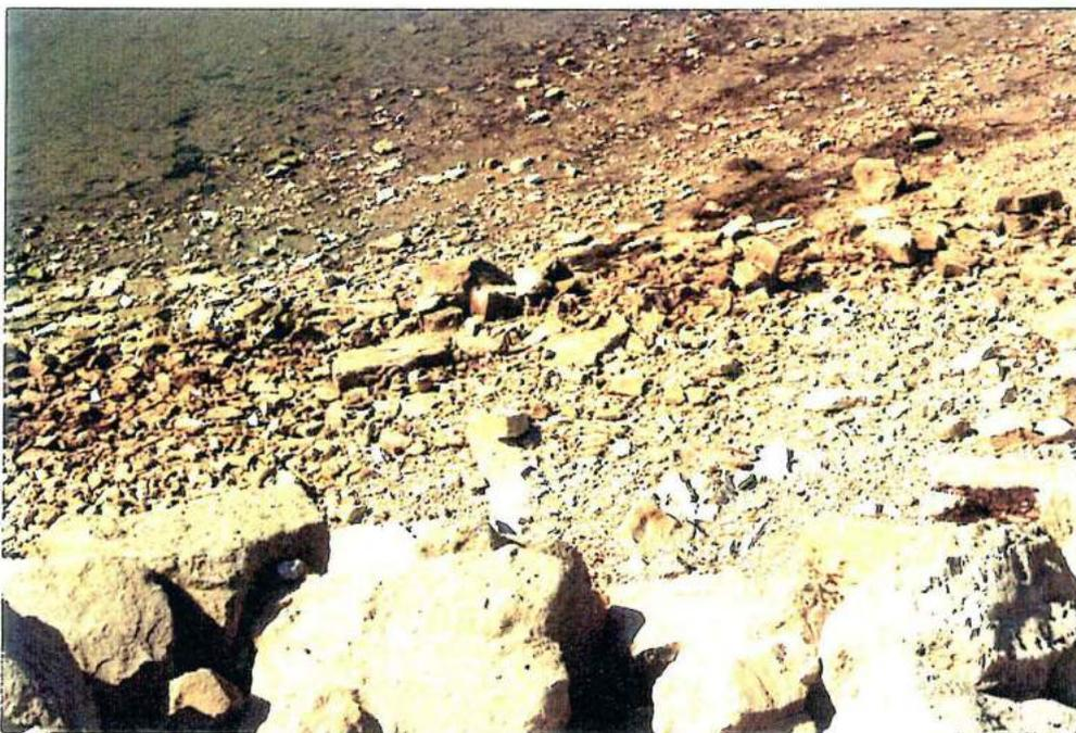
*Fig. 26. Lac du Der. Site d'enrochements anciens. Les blocs sont totalement fragmentés.*
