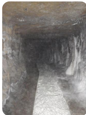
Figure : photo de la galerie principale
