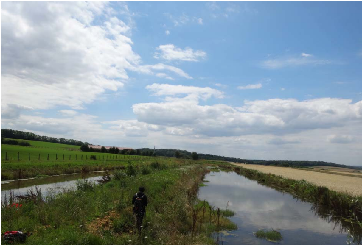
Fig. 1 Vue d'ensemble vers l'ouest des deux bassins d'infiltration au 15 juillet 2014.
